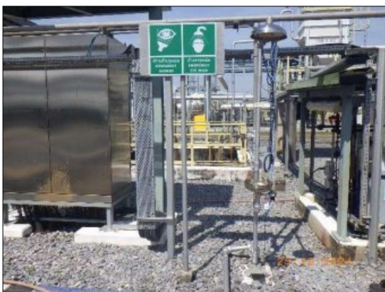
รูปที่ 2-50 การติดตั้งฝักบัวฉุกเฉิน ที่ล้างตาฉุกเฉิน บริเวณโรงแยกก๊าซธรรมชาติ ไทย-มาเลเซีย
