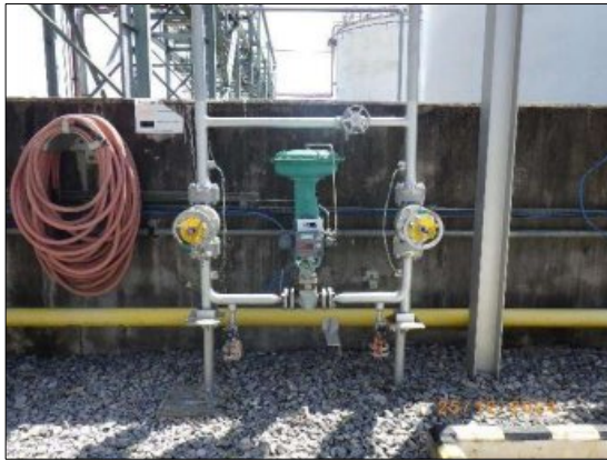
รูปที่ 2-61 วาล์วปิดกั้นระบบ (Shutdown valve) บริเวณพื้นที่ลานถังเก็บสำรองผลิตภัณฑ์
