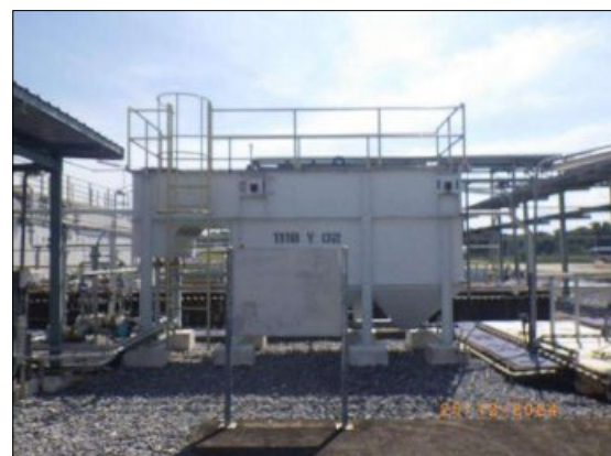
รูปที่ 2-22 หน่วย Flotation unit เพื่อให้ไขมันที่เหลือแยกตัวออกจากน้ำ
