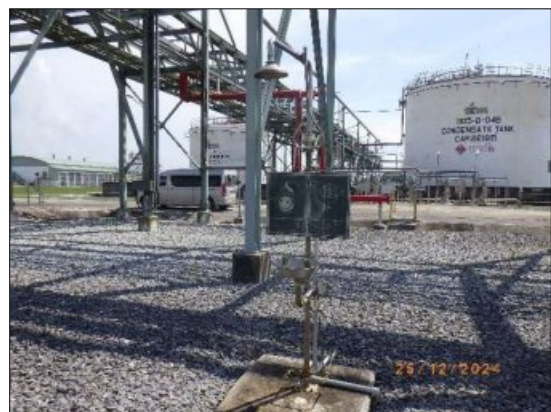
รูปที่ 2-50 การติดตั้งฝักบัวฉุกเฉิน ที่ล้างตาฉุกเฉิน บริเวณโรงแยกก๊าซธรรมชาติ ไทย-มาเลเซีย
