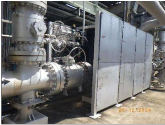
รูปที่ 2-12 การติดตั้งอุปกรณ์ป้องกันเสียงและดูดซับเสียง
