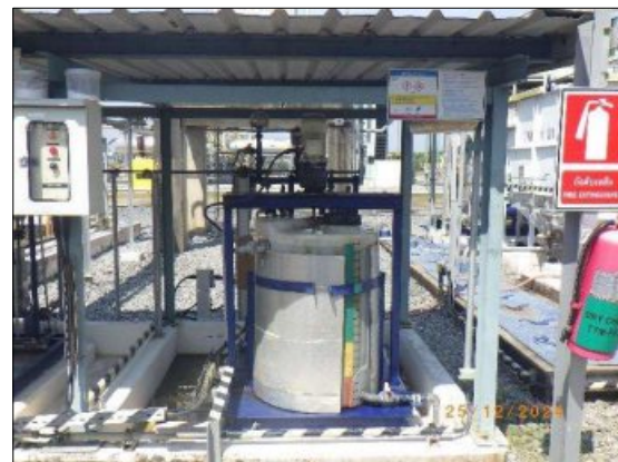
รูปที่ 2-20 การเติมสารเคมี Flotation agent เพื่อเพิ่มประสิทธิภาพในการแยกน้ำมันที่เหลือ ออกจากน้ำ
