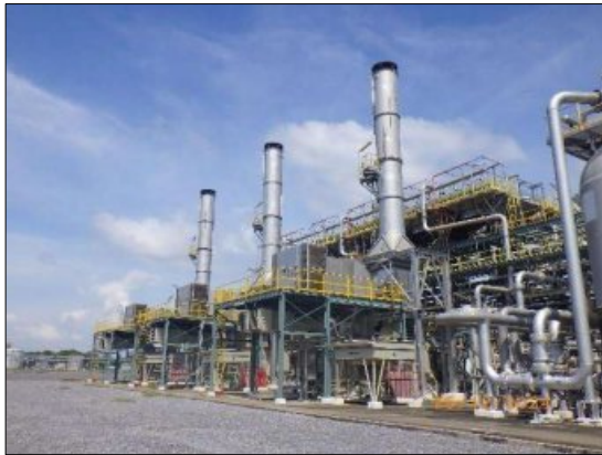
รูปที่ 2-6 เครื่องกังหันก๊าซที่ใช้ขับเคลื่อนเครื่องเพิ่มความดันก๊าซ (Gas Turbine Compressor) และการติดตามตรวจสอบคุณภาพอากาศจากปล่องระบาย
