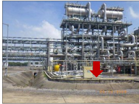
รูปที่ 2-28 คังปูนกั้นระหว่างพื้นที่กระบวนการผลิตกับพื้นที่ส่วนอื่น ๆ
