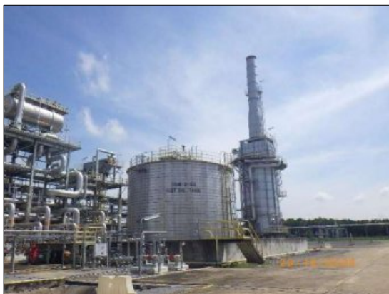
รูปที่ 2-7 Hot Oil Heater และการติดตามตรวจสอบคุณภาพอากาศจากปล่องระบาย
