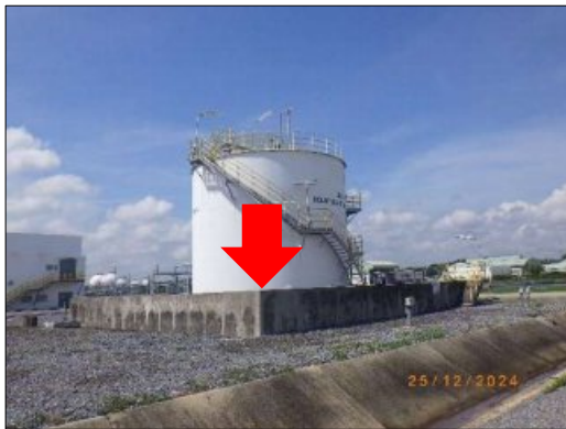
รูปที่ 2-63 พื้นที่จัดเก็บสำหรับ NGL tanks, Hot oil tank, Diesel storage tank ที่มีคันล้อมรอบเพื่อป้องกันการหกรั่วไหล
