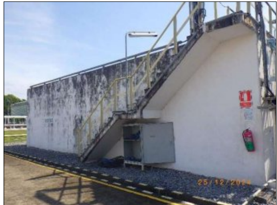
รูปที่ 2-25 ป้อมตรวจสอบคุณภาพน้ำ จำนวน 4 ป้อม ขนาดความจุ้บ่อละ 360 ลูกบาศก์เมตร
