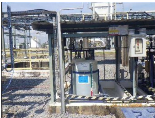
รูปที่ 2-19 การเติมสารเคมี Demulsifier ก่อนเข้าสู่ CPI เพื่อเพิ่มประสิทธิภาพในการแยกตัวของน้ำมัน หรือของแข็งออกจากน้ำเสีย
