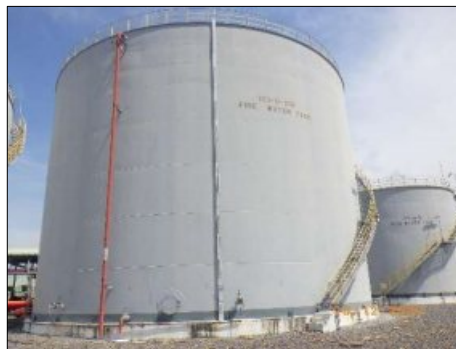
รูปที่ 2-56 ถัง Fire water tank เพื่อสำรองน้ำดับเพลิง
