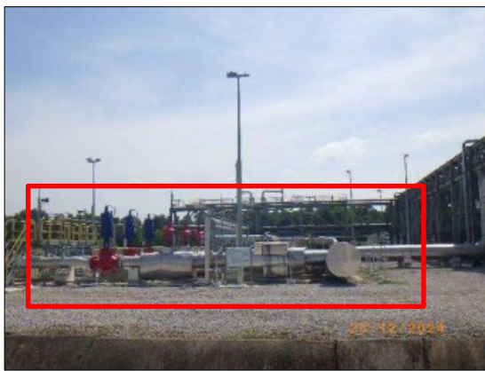
รูปที่ 2-13 ติดตั้งตัวปรับลดเสียง และฉนวนดูดซับเสียง ห่อหุ้มที่วาล์ว
