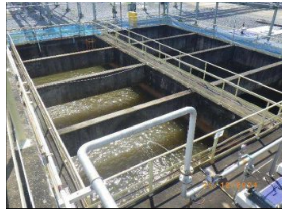
รูปที่ 2-18 บ่อรับน้ำเสียที่มีการปนเปื้อน (Contaminated Water Receiving Sump)
